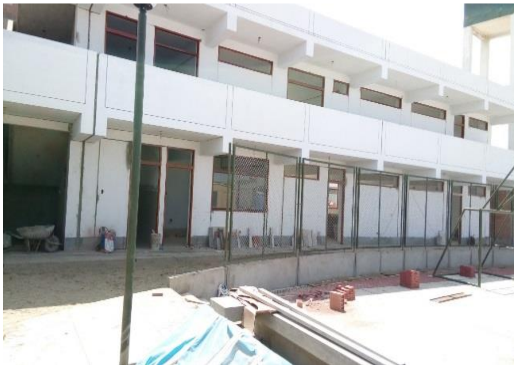
IE en proceso de construcción, ambientes administrativos y pedagógicos.
