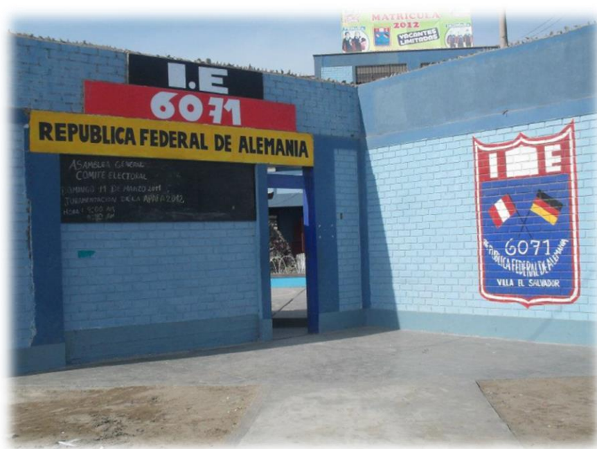
Vista parcial de Institución Educativa n° 6071 “República Federal de Alemania” Fuente: Fotografiado propio
