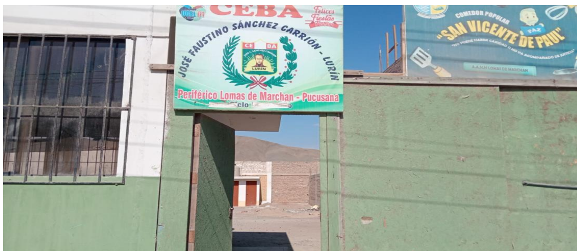
Puerta de ingreso al CEBA José Faustino Sánchez Carrión
