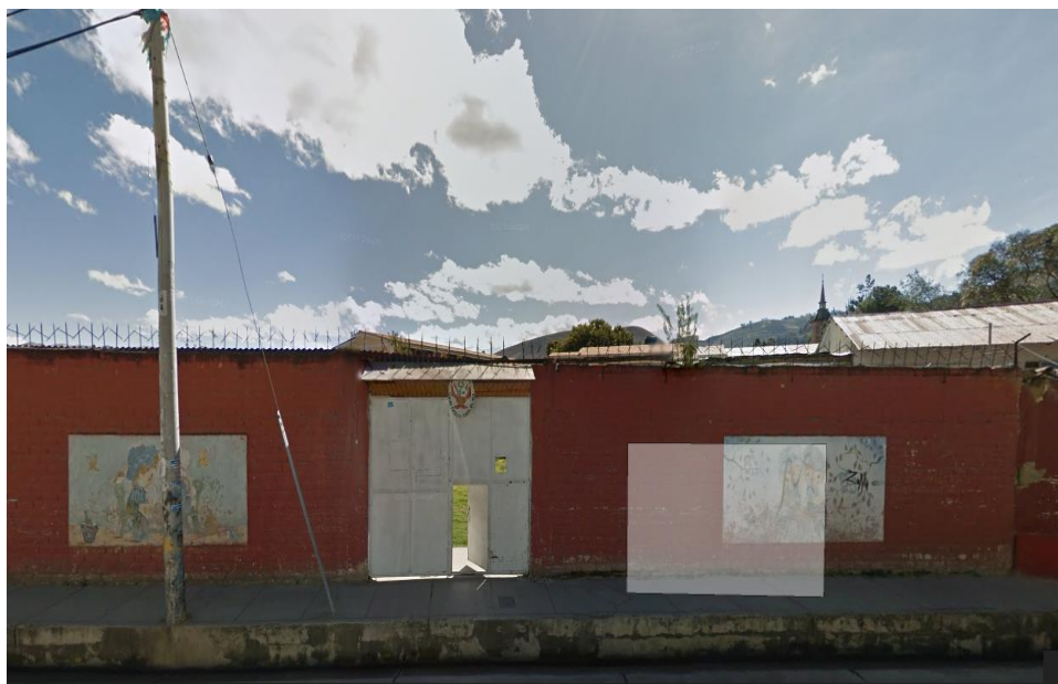
Figura 2. Fachada del PRITE “Señor de la Divina Misericordia” en Prolongación Pachacutec N°226 en el distrito de Baños del Inca Cajamarca.
