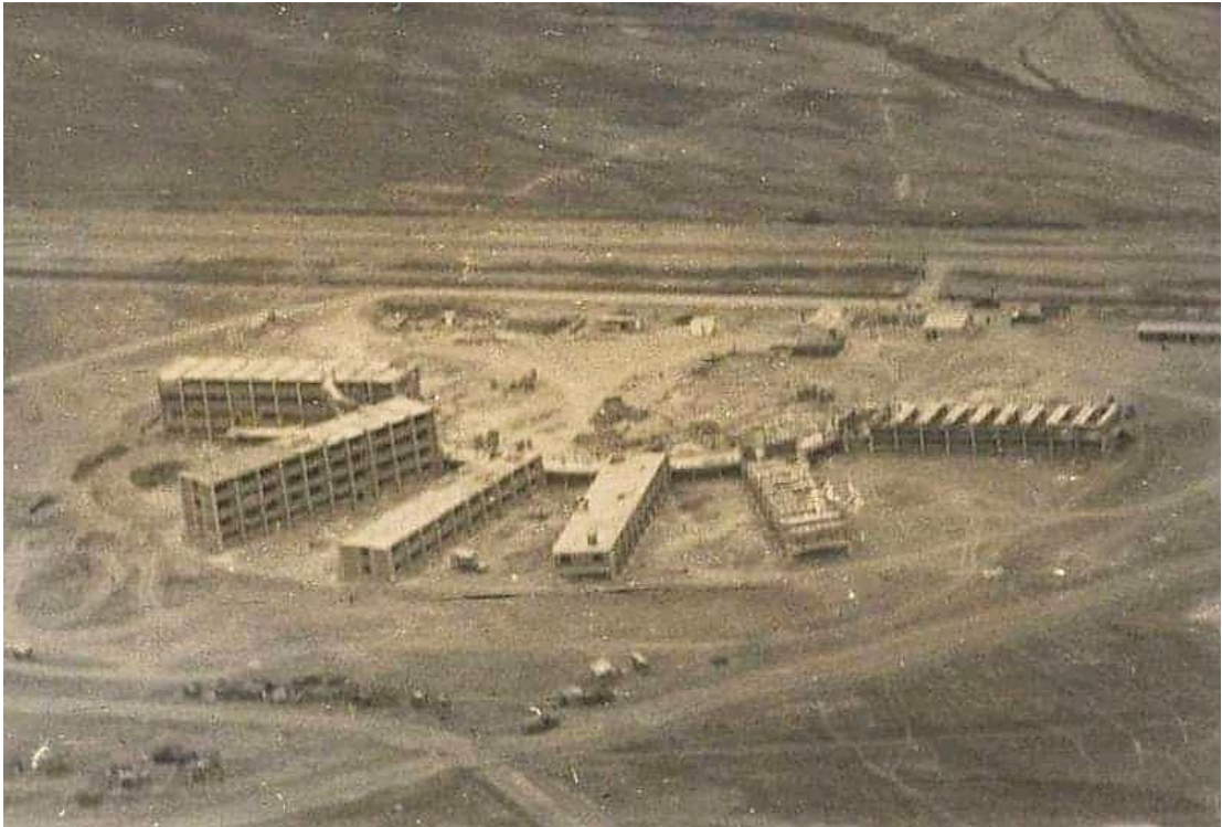
Figura 3. Fotografía del Instituto Pedagógico Nacional Monterrico durante su construcción.
